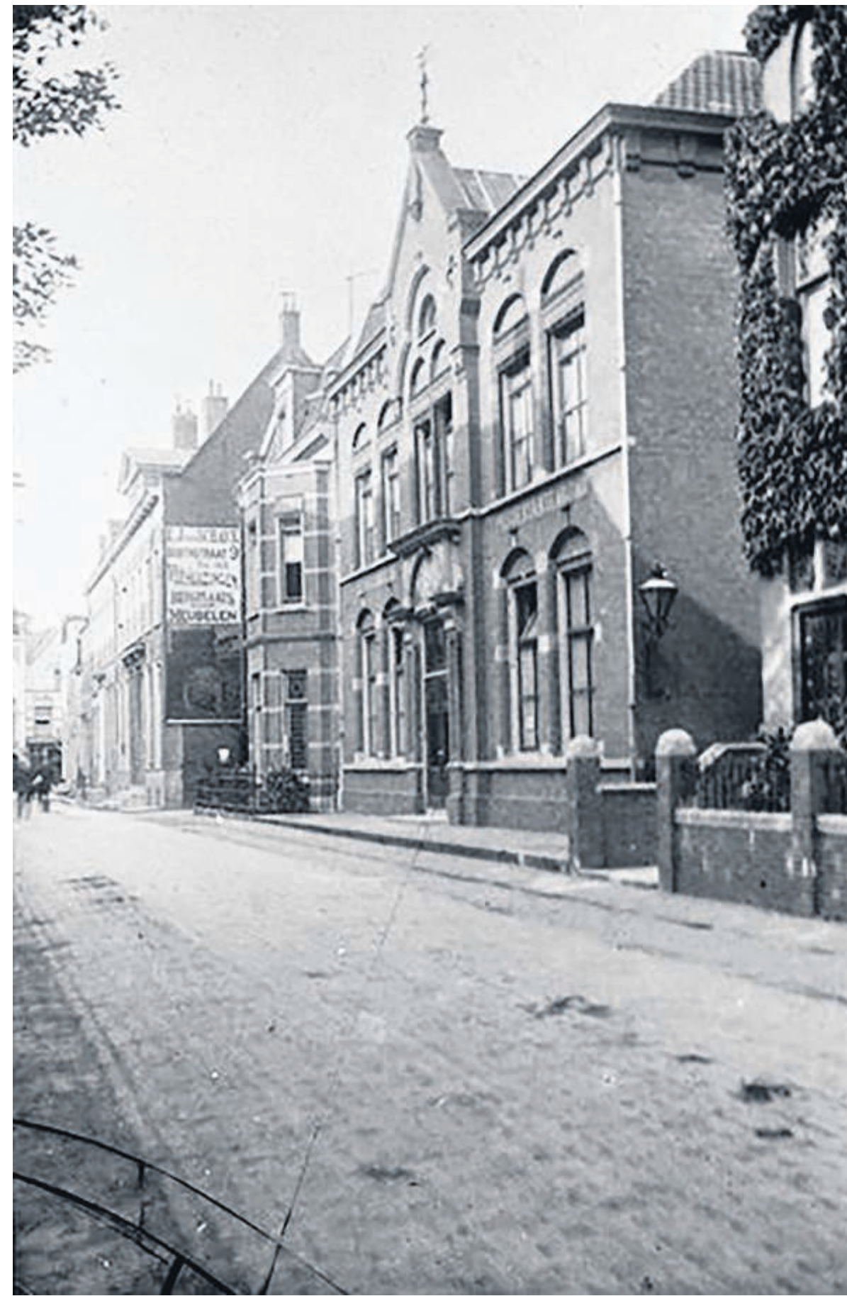
Het kerkgebouw aan de Boothstraat in Utrecht, waar in 1953 de generale synode van de Gereformeerde Gemeenten werd gehouden. Het ontslag van dr. Steenblok als docent aan de Theologische School te Rotterdam luidde de scheuring in waaruit de Gereformeerde Gemeenten in Nederland ontstonden. beeld uit besproken boek
